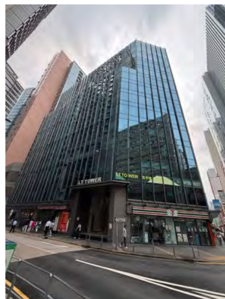
觀塘創業街 31 號 LT Tower (圖片來源：永利行圖庫)
