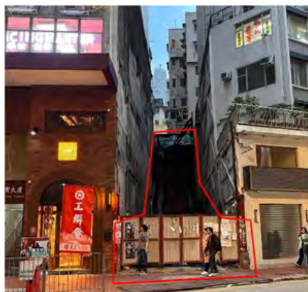
皇后大道中182號地盤 (西營盤及上環大綱圖之內) (圖片來源：永利行圖庫)
