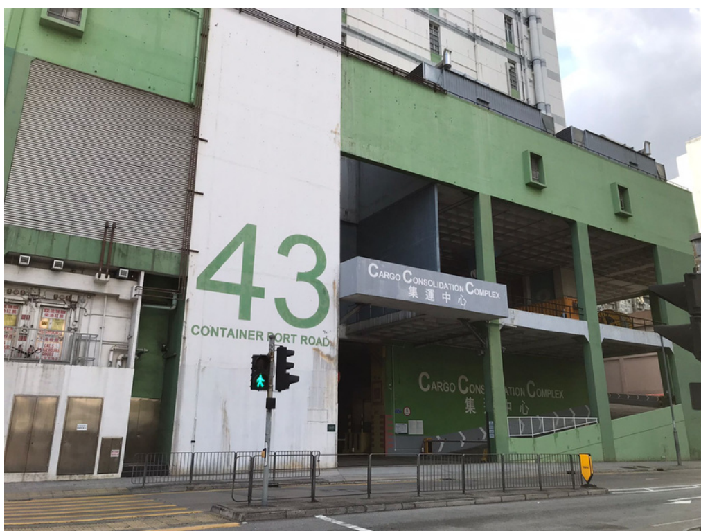
位於葵涌貨櫃碼頭路四十三號的集運中心 (圖片來源：永利行圖庫)
