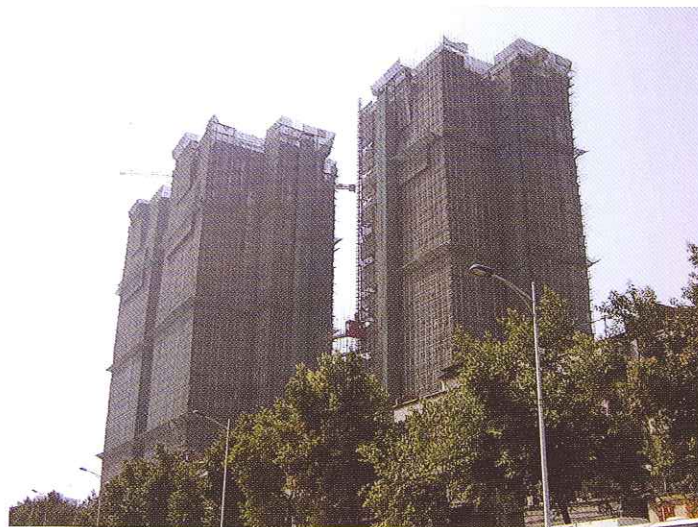
廣州站前路的一個在建項目
